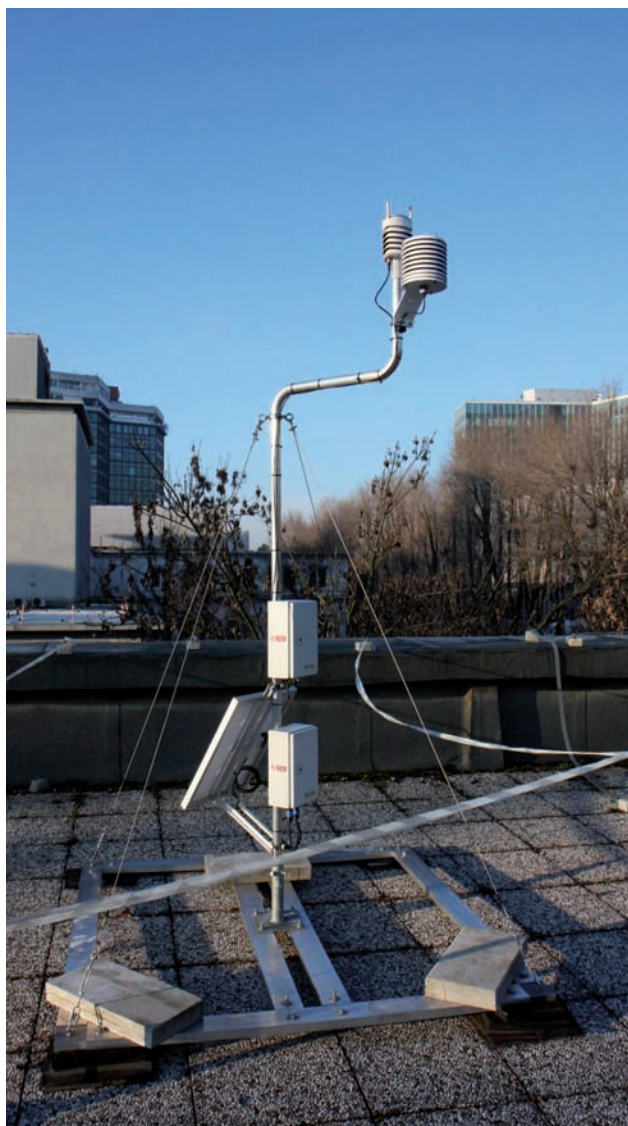
Strumentazione per misurazioni meteorologiche installata presso la SSC
